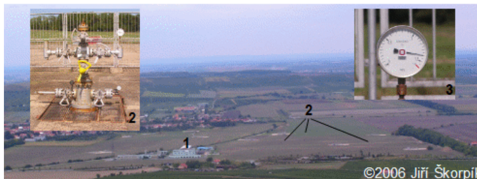
692 Podzemní zásobník plynu Dolní Dunajovice
