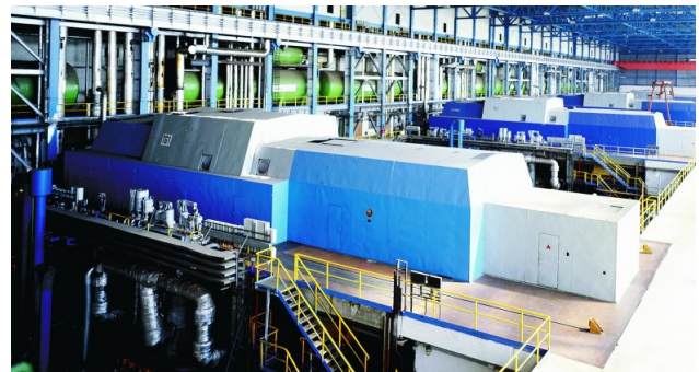
168 Uspořádání turbosoustrojí 4x200 MW ve strojovně elektrárny Dětmarovice Obrázek z [9].
