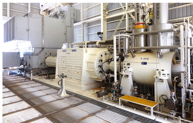
647 Soustrojí s turbokompresorem a hydrodynamickou převodovkou Soustrojí o výkonu 20 MW a maximálními otáčkami 8\,000\text{ min}^{-1} [49]. Kompresorová část je spojena s elektromotorem přes hydrodynamickou převodovku řady Vorecon od společnosti Voith GmbH.
