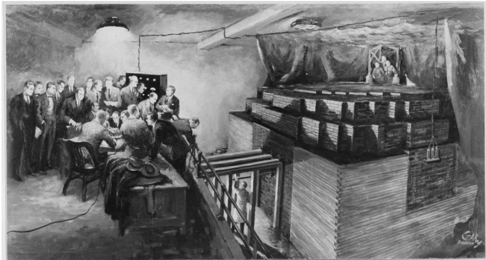
Prosinec 1942 Chicago – kresba zachycuje spuštění prvního jaderného reaktoru. Všimněte si ruční manipulace s regulační tyčí. Autor obrázku je Gary Sheehan (1957) [Wikimedia Commons].
