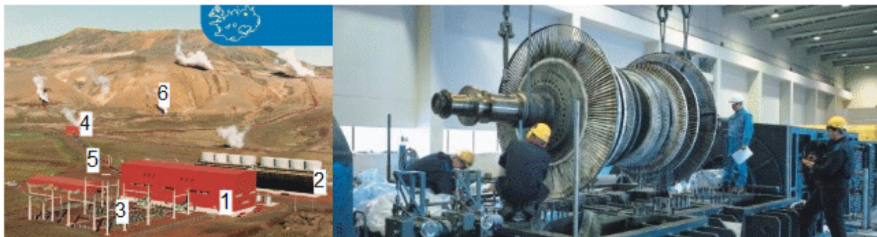
1115 Geotermální elektrárna Krafla 2x30 MW (Island) a výměna rotoru turbíny
